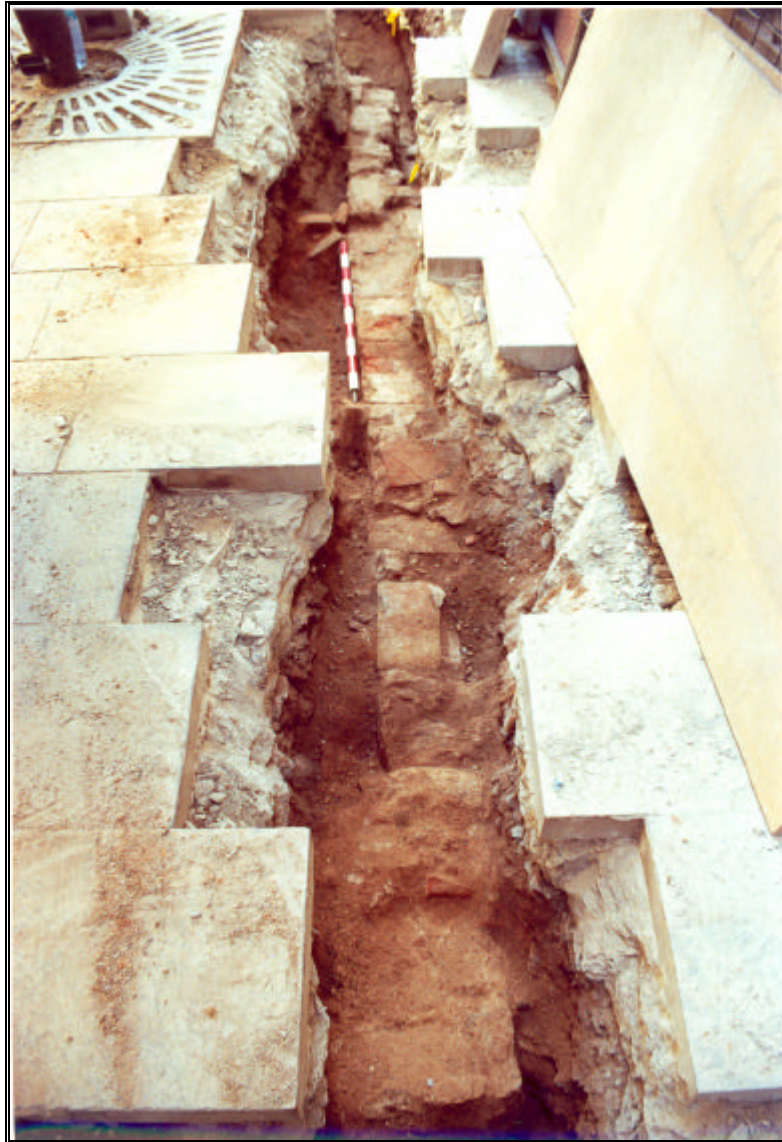
Fot 3. Vista del mur 12 en el seu tram final i el mur 18 que se li adossa.
