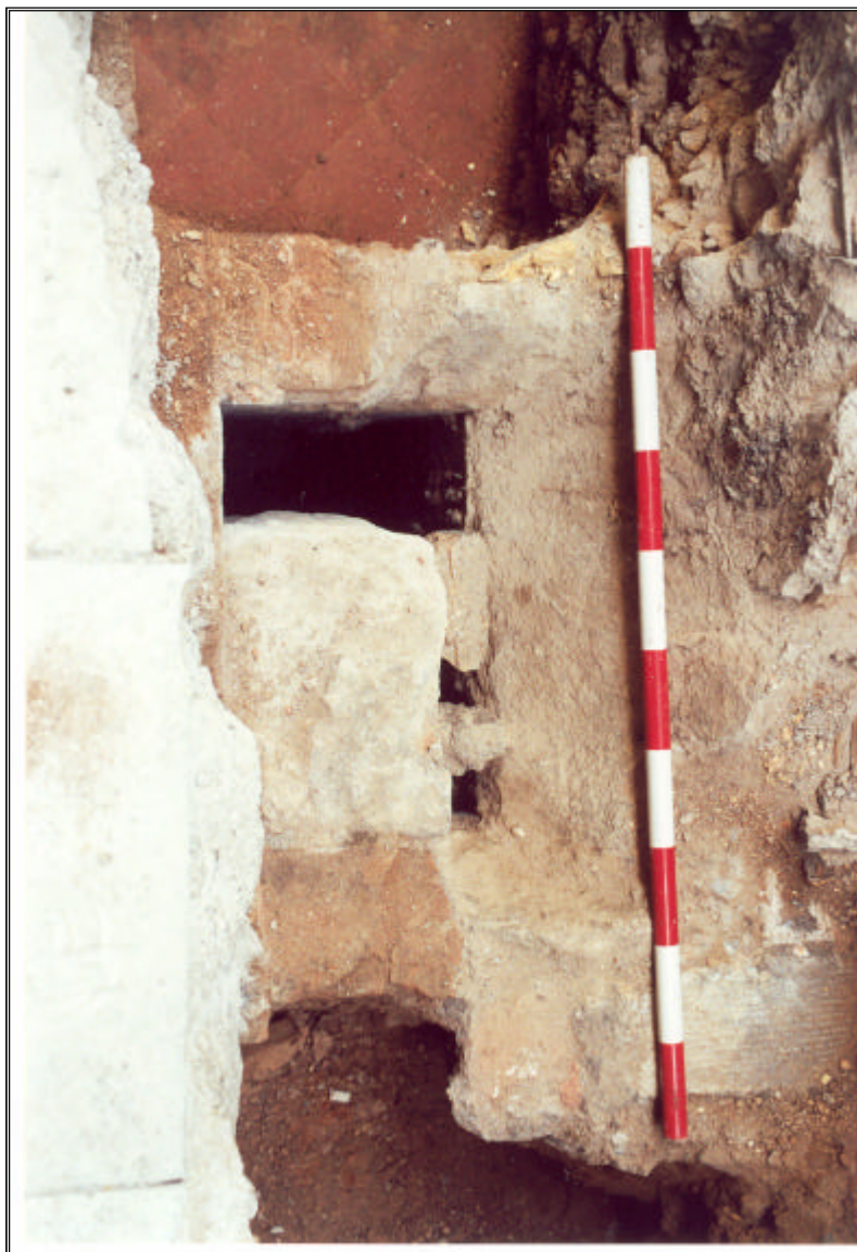
Fot. 6 Vista de l'arqueta que connecta amb el col·lector.
